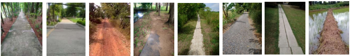
ภาพที่ 5 แสดงลักษณะพื้นทางเดินแบบต่างๆ (คอนกรีต/ยางมะตอย/ลูกรัง/ดิน/น้ำ)
